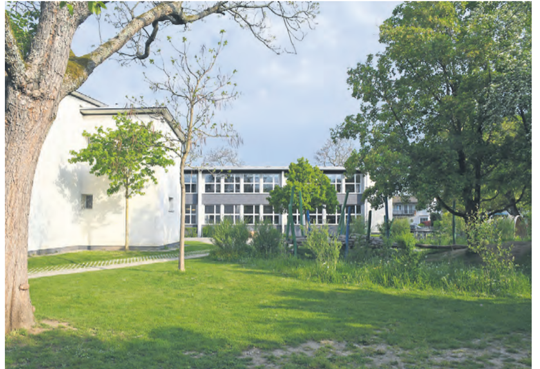
Das Hebelschulhaus, das eine Grünraumaufwertung bekommen soll, mit einem Teil des Schulgartens vom Innern des Schulareals her gesehen.
